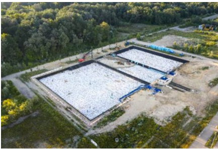
Abbildung 1: Bau des INTERSTORES-Demonstrators Reno-sTES in Ingolstadt. Bild: Audi Event Solutions GmbH.
